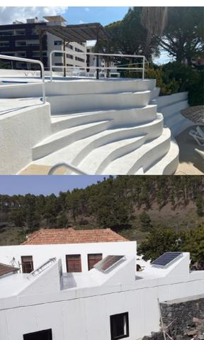
► **COMO RECUBRIMIENTO TÉRMICO REFLECTANTE EN CUBIERTAS, EN COMBINACIÓN CON OTROS SISTEMAS:**
